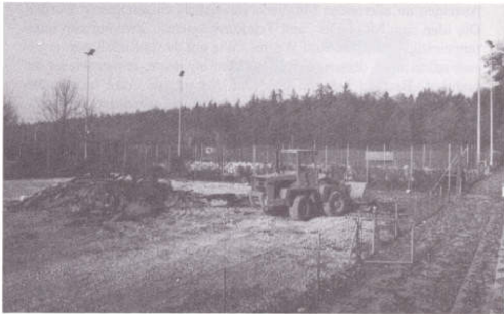
Schon wieder wird gebaggert...
