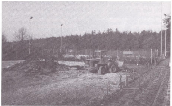
Schon wieder wird gebaggert...
